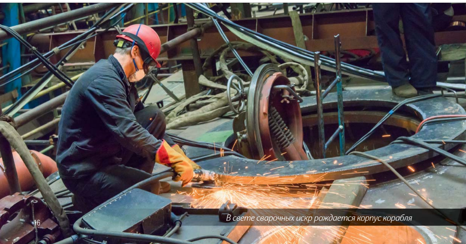
Работники предприятия на строительстве крейсера
