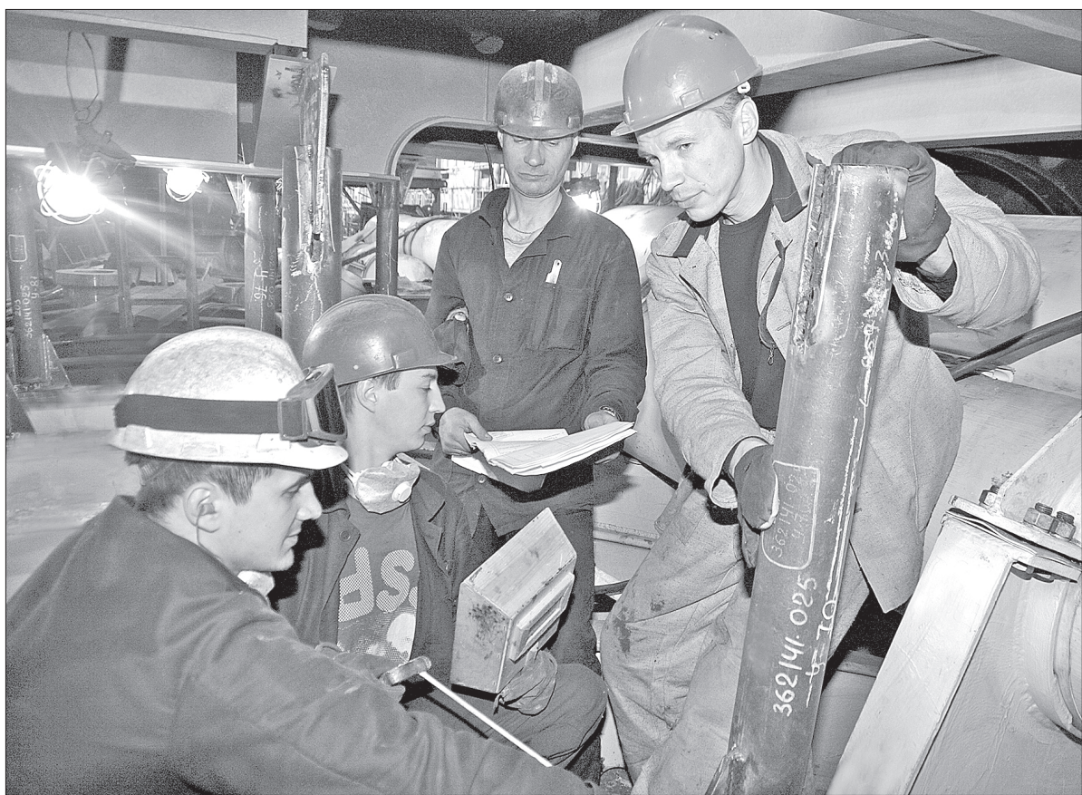
Сборка металлоконструкций в отсеке АПЛ: А. Замыслов, А. Данилушкин, А. Налётов, В. Сидоров
