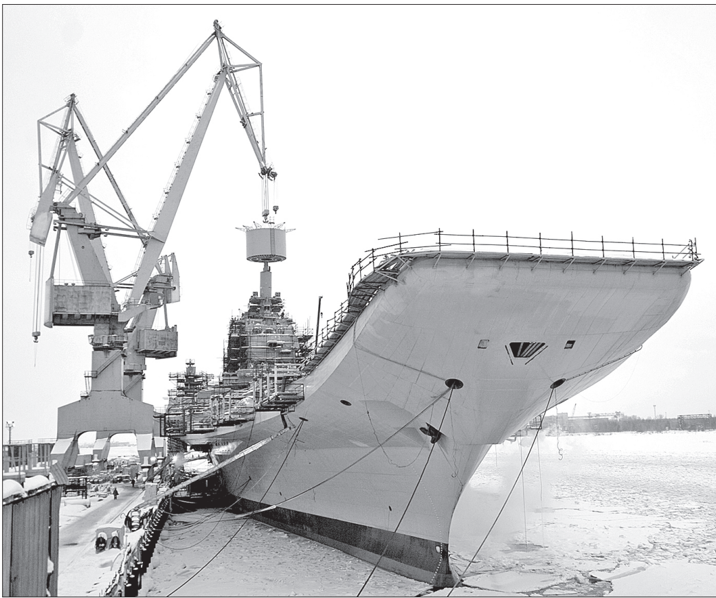
Ответственный момент: установка барабана с антенными постами на авианосец
